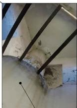
FOTOGRAFIA 47 FONTE: DO AUTOR TRILOS UTILIZADOS PARA SUPORTE DO ANTIGO PISO
