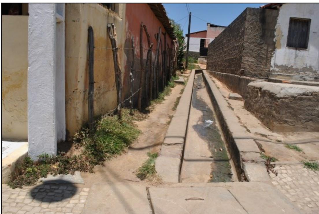
FOTO 29 - GALERIAS DE ÁGUAS PLUVIAIS INADEQUADAS NO POLO MACIÇO DE BATURITÉ.
