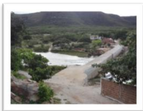
Figura 12. Barragem da Barra do Sotero
