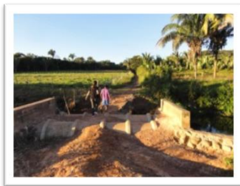
Figura 94. Reserva Ecológica – acesso interditado na rodovia
