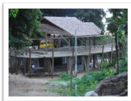
Figura 58. Construção do restaurante
