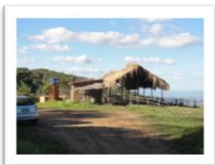
Figura 80. Barracão onde está instalado bar do mirante
